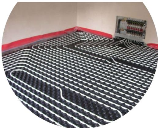
***La bandella perimetrale, il pannello isolante con la tubazione e il collettore costituiscono l'impianto a pavimento.***
